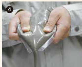
4 パックの切り込み部をカットしてモルタルを押し出します。
